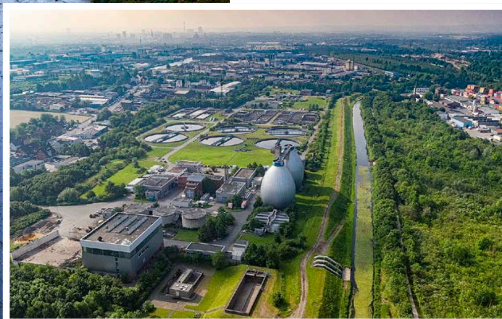
Die Emscher-Großkläranlage in Dortmund-Deusen wird ab diesem Jahr von der Emschergenossenschaft weiter modernisiert.
