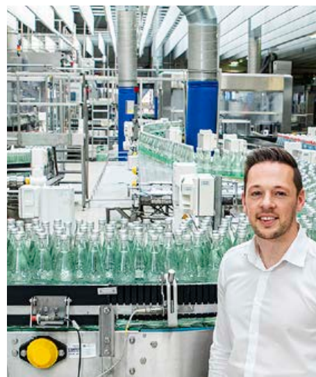
Mit der Abwärme von Hochdruckkompressoren für die Getränkeabfüllung heizen? Geht!
